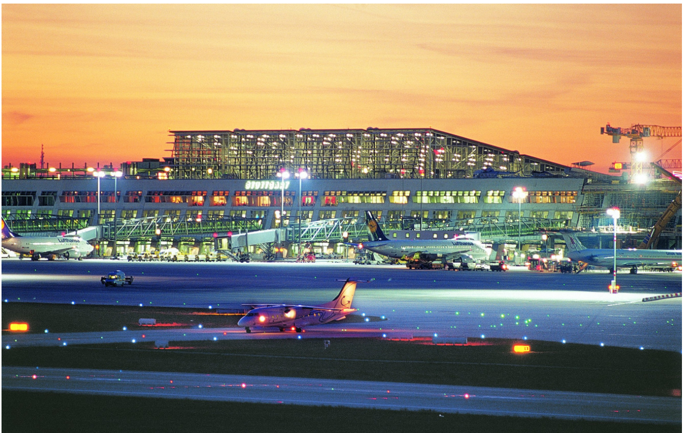
Bild 5; Flughafen Stuttgart GmbH
